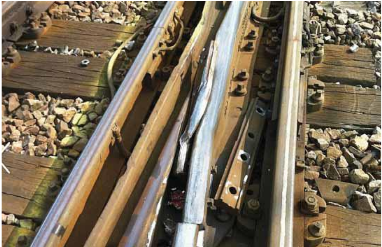
L'éclisse retrouvée dans le cœur de traversée, à l'origine du déraillement
