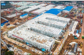
Hôpital « construit en 10 jours ». DR
